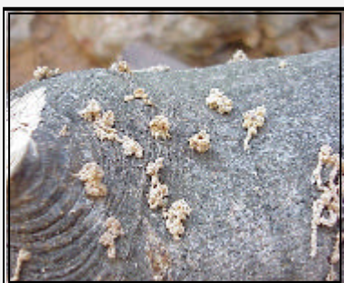
Orificios con aserrín
