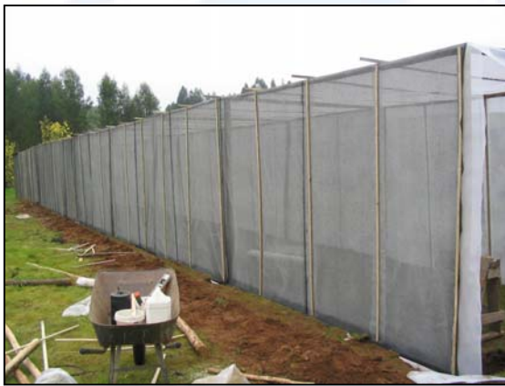
Fase de construcción cuarentena
